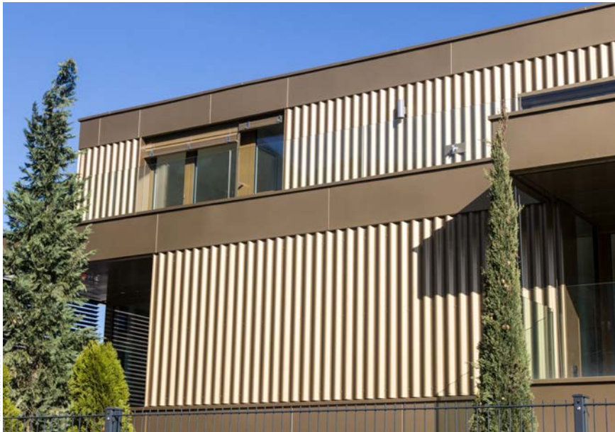
Je nach Sonneneinstrahlung ändern sich Struktur und Schattierung der pulverbeschichteten Metallfassaden.
